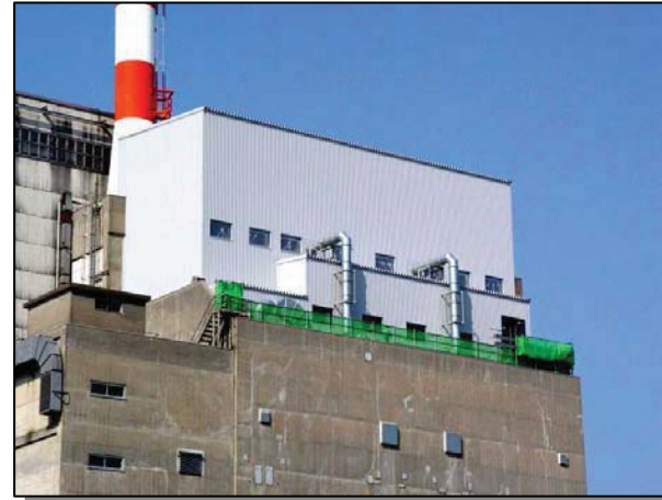
【仮設建屋の組立状況】
