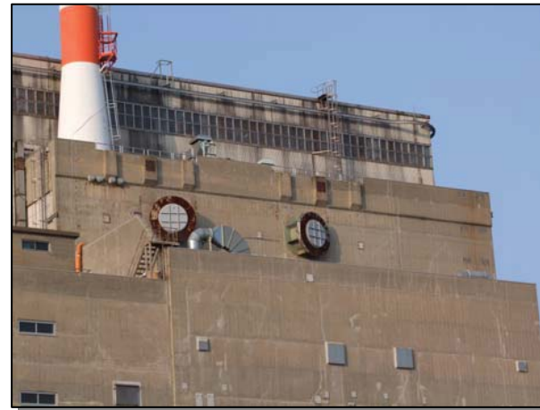
【撤去完了後の状況】
