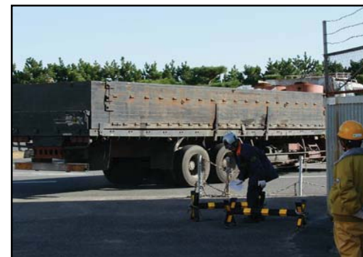
(搬出作業:H20.11月～H21.2)
