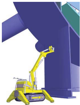
圧力容器/アスベスト: 事前撤去が必要
