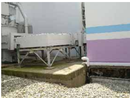
地盤沈下, 2号機 (-)
