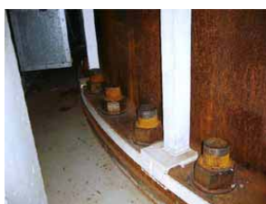
UTによる基礎ボルトの検査結果(圧力容器基礎ボルト)
