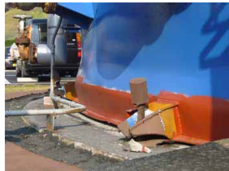
NO.3ろ過水タンク
