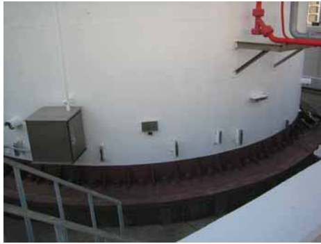
7号機軽油タンク
