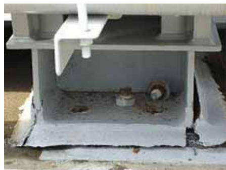
変圧器基礎ボルト, 2号機 (C)
