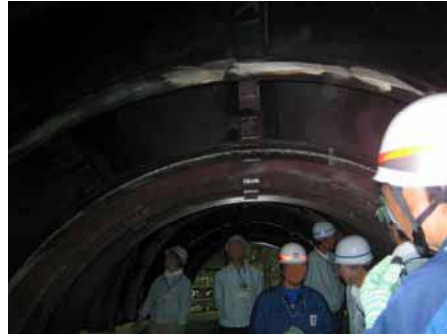
タービン車室内部, 1号機 (B)
