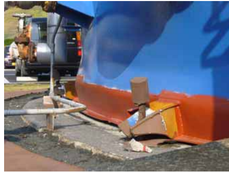
NO.4ろ過水タンク (C)
