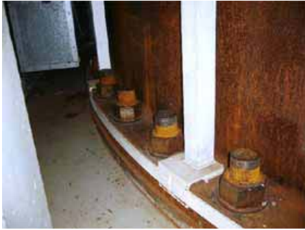
RPV基礎ボルト, 1号機 (As)
