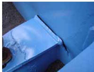
基礎ボルト及びブラケットの損傷 ろ過水タンクからの漏えい
