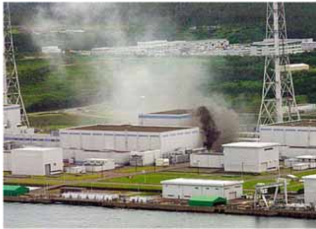
所内変圧器の火災
