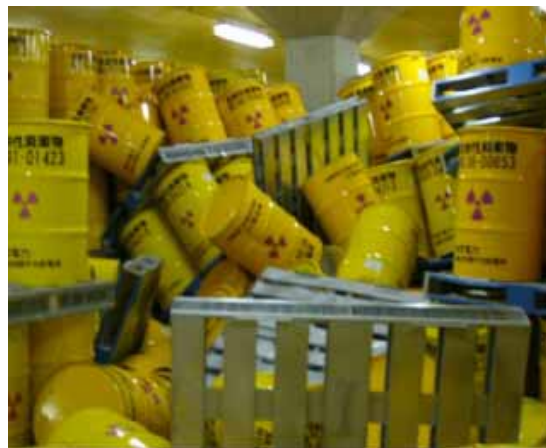
固体廃棄物貯蔵施設におけるドラム缶の転倒
