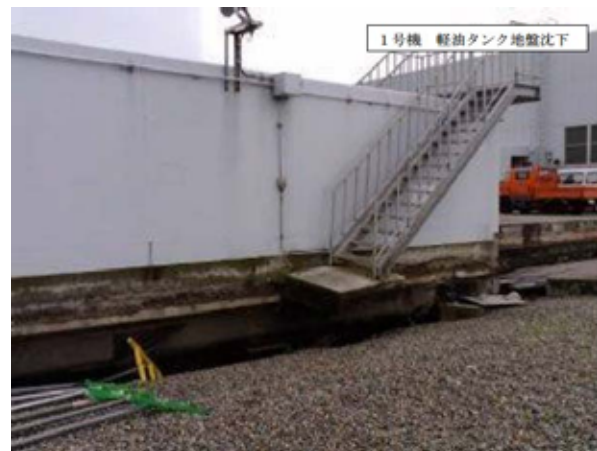
1号機軽油タンクの損傷
