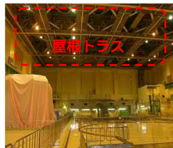
原子炉建屋屋根トラス
