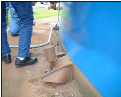
基礎ボルト及びブラケットの損傷 ろ過水タンクからの漏えい
